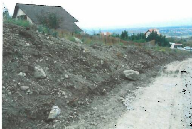
Szomszédos, 7211/5 hrsz.-ú ingatlan felől
